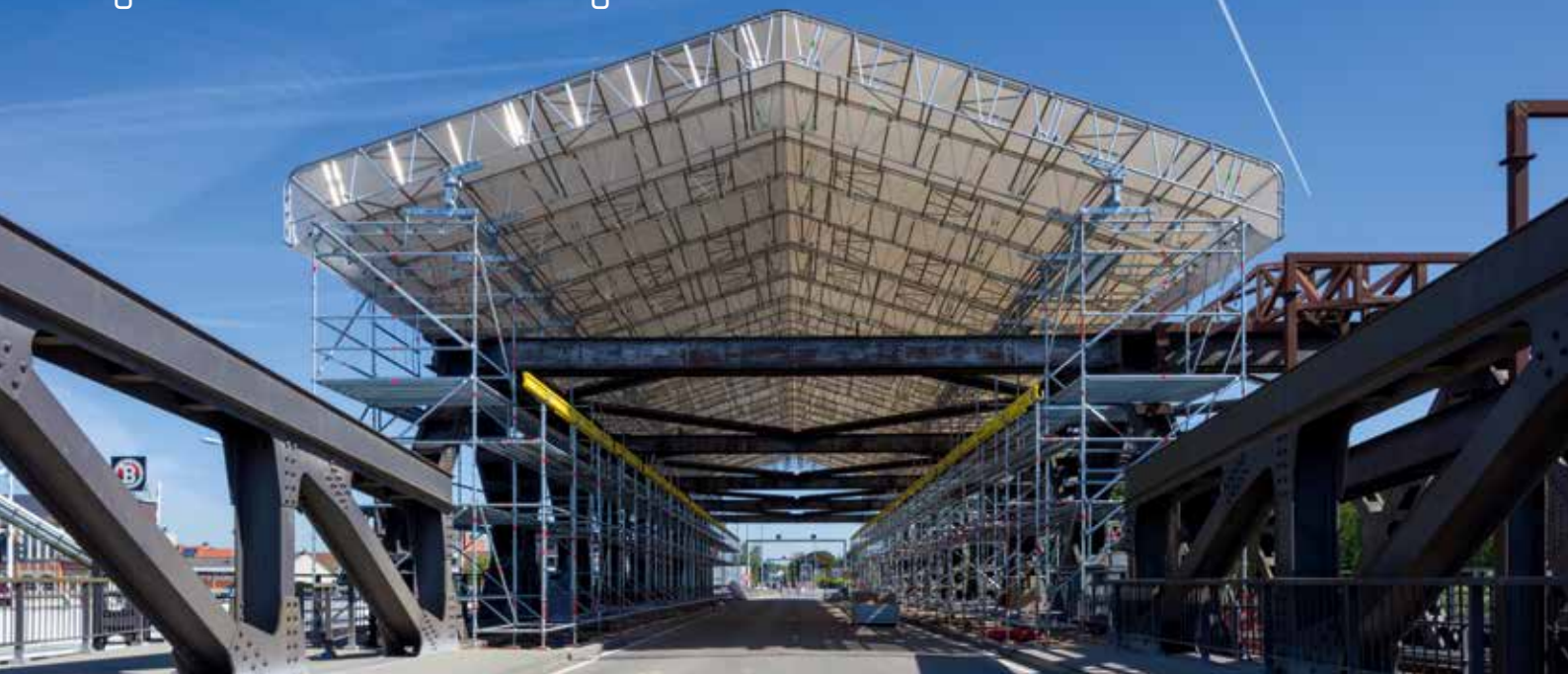
Een rijdend dak op de brug van Temse zorgde voor een vlotte renovatie.
